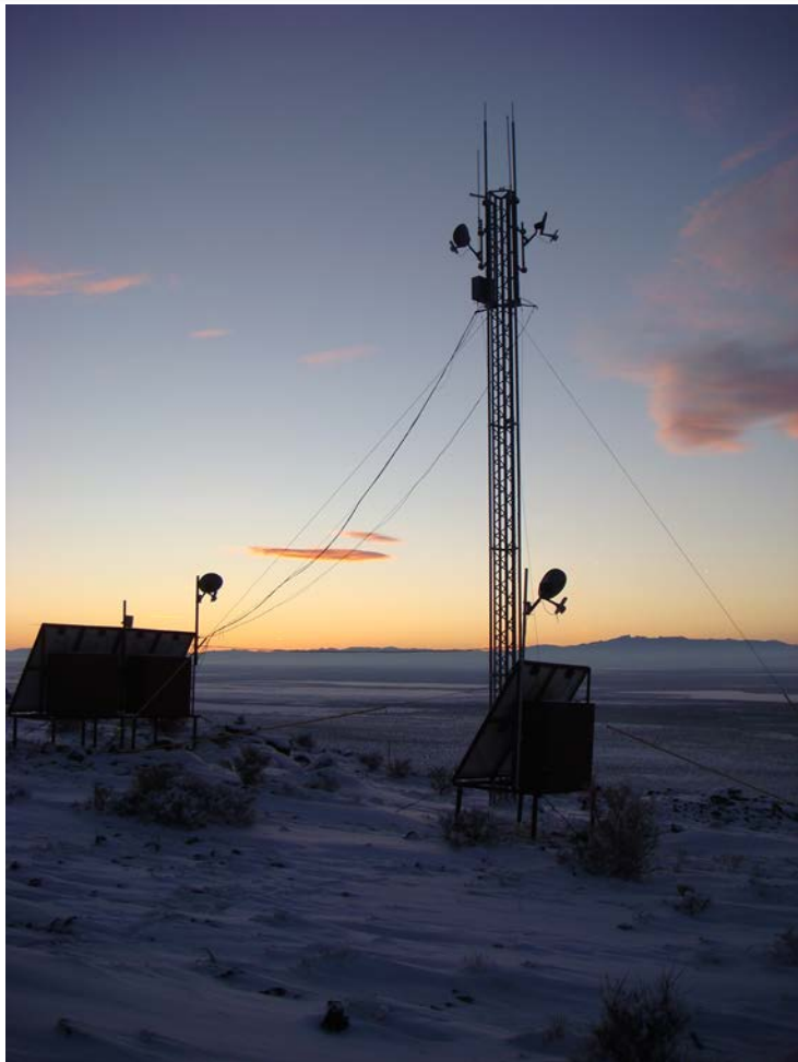
通信塔本体とアンテナ群
