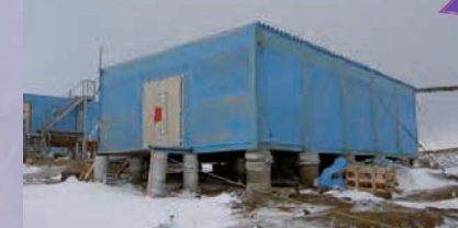
観測倉庫（1970年建設）
