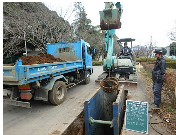
埋設配管整備
