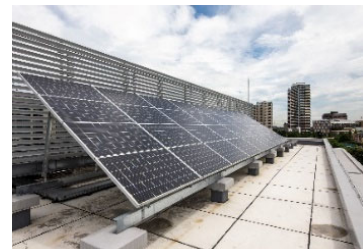
太陽光発電設備
