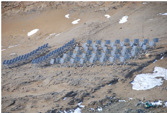
昭和基地の太陽光発電設備
