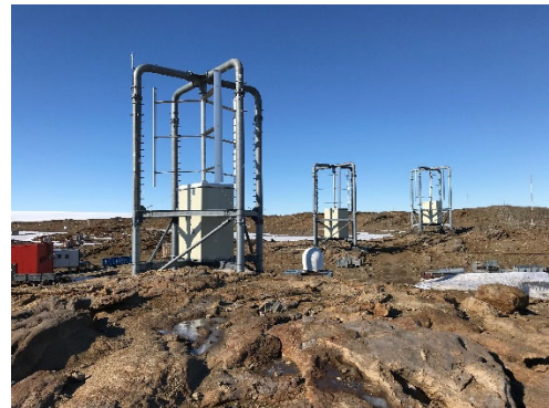
昭和基地の風力発電設備（縦軸型）
