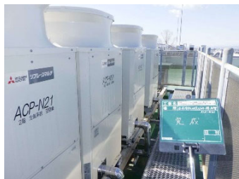
高効率空調機
