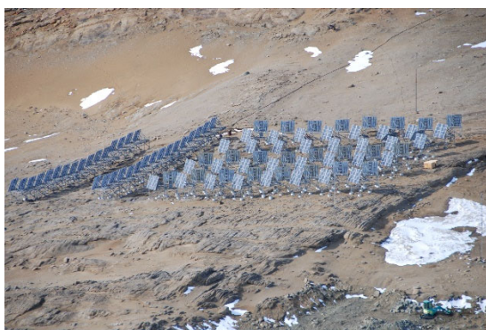
昭和基地の太陽光発電設備
