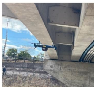
床版及び支保点点検のため飛行するSkydio 2+
